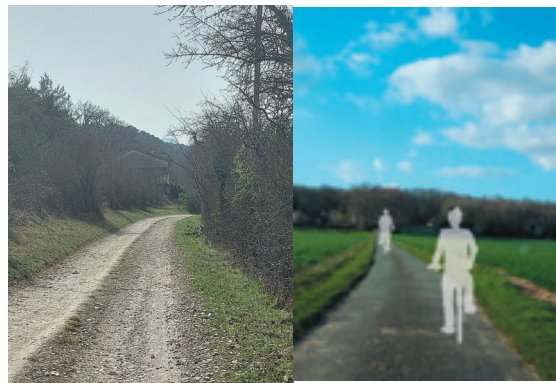
Exemple de chemin agricole à réaménager (A)
