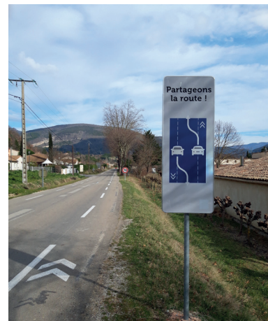
Chaussée à voie centrale banalisée (CVCB), Saillans
