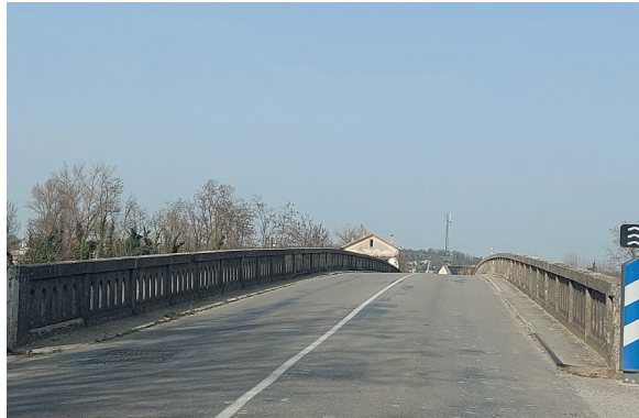
Franchissement sur la RD125 entre Alex et Grâne
