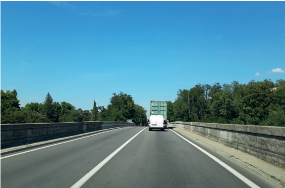
Franchissement sur la RN7 entre Livron et Loriol
