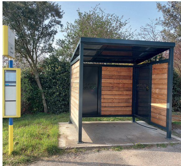
Arrêt de transports en commun équipé d'un abris-bus avec arceaux, installé prochainement à Eurre.
