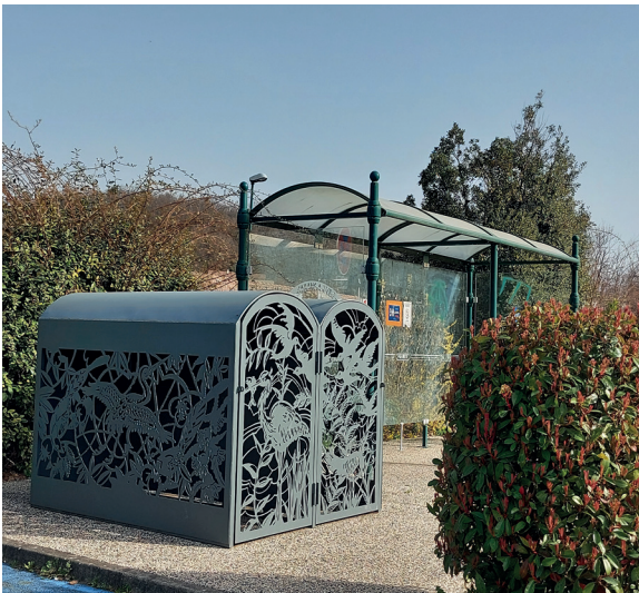
Arrêt de transports en commun équipé de consigne vélo, à Montoisson.
