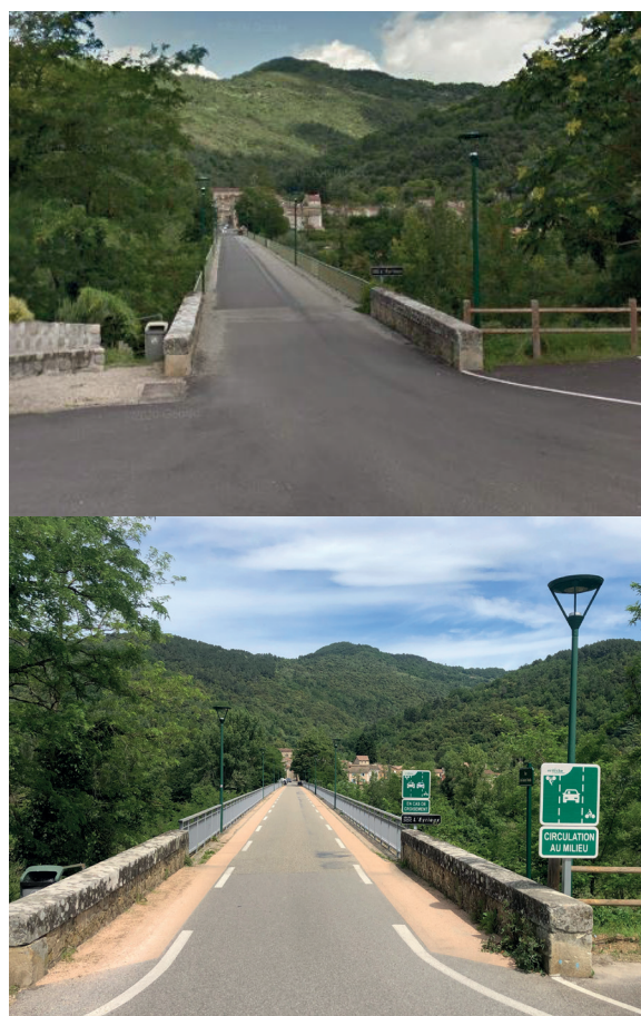
Exemple d'un pont sécurisé pour les cyclistes avec une CVCB : Avant (en haut) / Après (en bas), Saint-Fortunat-sur-Eyrieux, Ardèche
