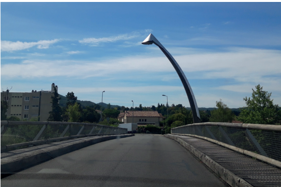
Pont entre le quai Pied Gai et le Quai André Reynier à Crest
