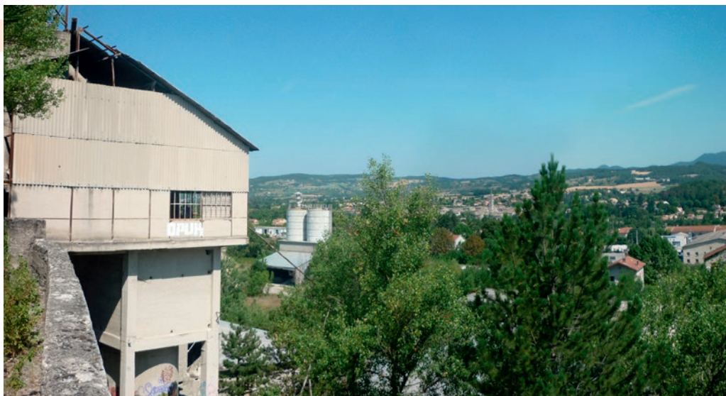
Ancienne zone Vicat, en cours de réhabilitation en écoparc
